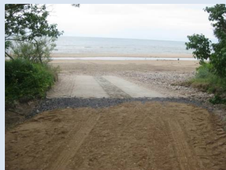
B labiekārtota nobrauktuve uz jūru Pāvilostā Tirgus ielas galā (foto: V. Ģēģere)
